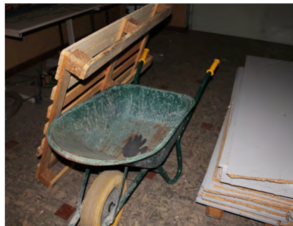
Bâtiment C Chantier 2016
