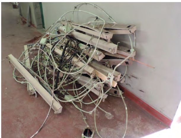
Bâtiment A Début des travaux 2013
