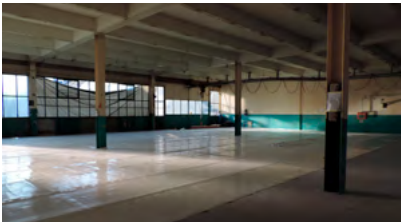
Bâtiment A Rez-de-chaussée 2014
