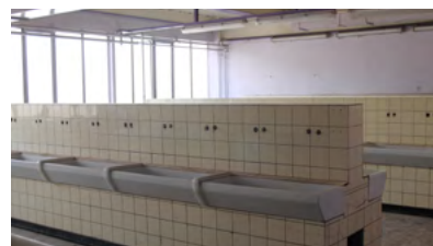
Bâtiment C Anciens vestiaires 2013
